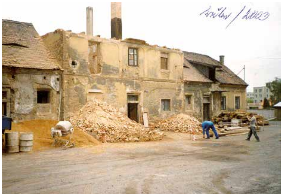
Květen 2003 – začínáme budovat obnovený majetek
